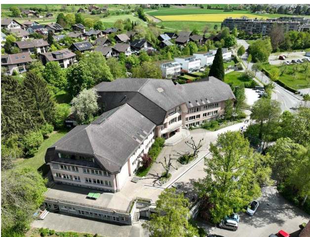
Das Schulgebäude in Ittigen
